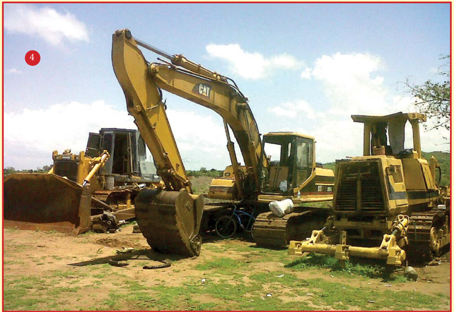
Mobilisation des équipements pour les travaux d'essouchement et défrichage du site de relocalisation.
