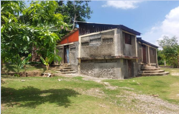
A: Bâtiment exploitant par RACOGA
