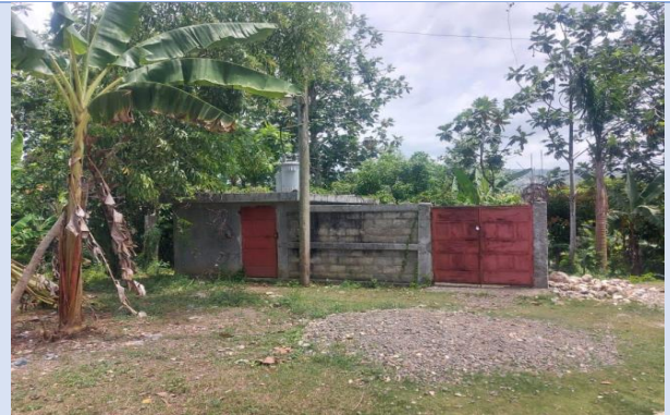
B: Bâtiment logeant le moteur
