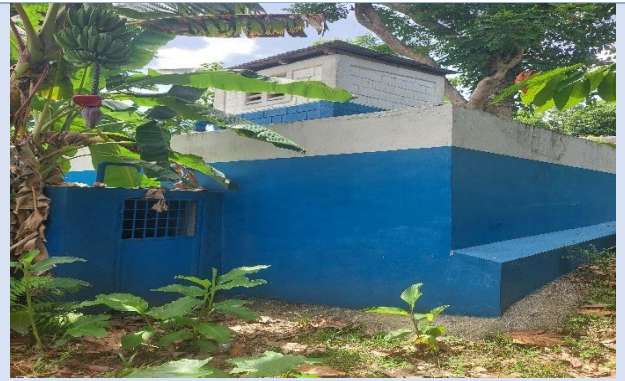
D: Réservoir de la DINEPA
